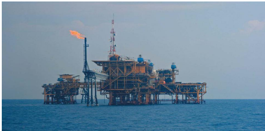
中海油在印尼的作业平台
